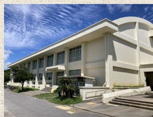
体育館(第1)※第2体育館もあり
