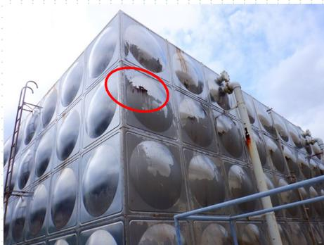
錆による受水槽の亀裂
