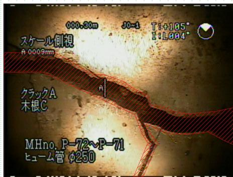
調査による配管の亀裂の発見
