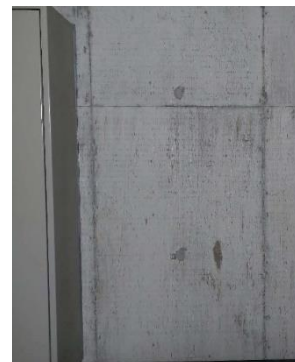
文系総合研究棟EPS （改修前）
