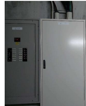
文系総合研究棟EPS （改修後）
