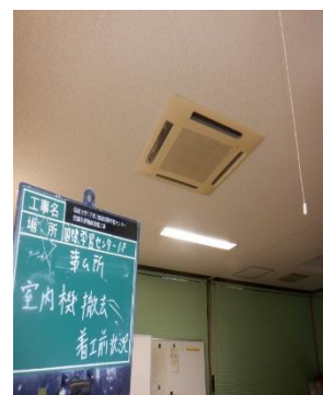
地域国際学習センター 1階事務所（改修前）
