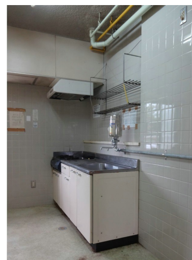
補食室改修前写真
