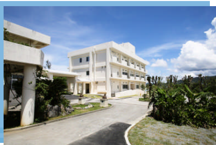
建物西側：渡廊下で既設建物と繋がる
