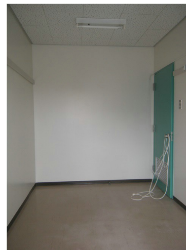
居室改修前写真
